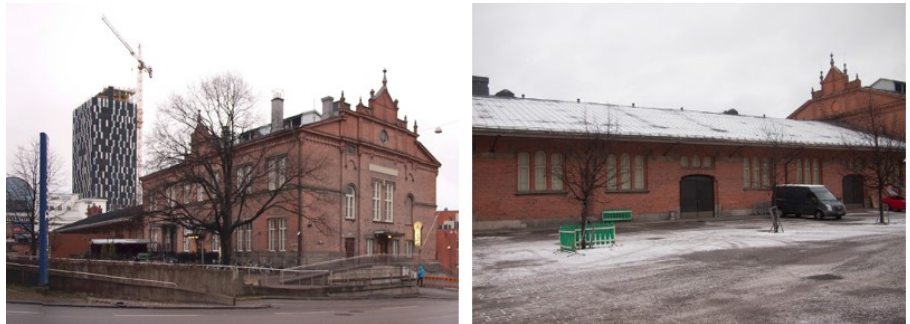
Tullikamari Itsenäisyydenkadulta ja Pakkahuone Tullikamarin aukion puolelta. KUVAT: Rakennetun kulttuuriympäristön selvitys
