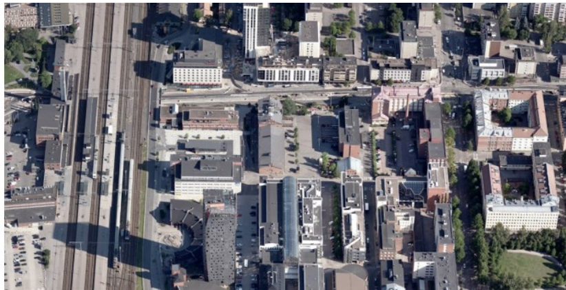
Vasemmalla: Tullin ruutukaava-alueen korttelirakenne. KUVA: Tampereen kaupunki Oikealla: Ilmakuva aukion ympäristöstä. KUVA: © 2018 BLOM
